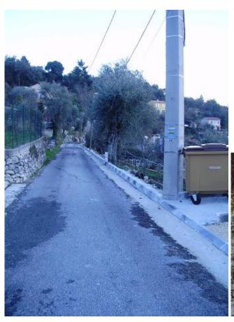
La troisième phase de travaux de gestion des eaux de ruissellement et d'élargissement au quartier des Tourrettes vient de s'achever. La pose de grilles, de caniveaux et de bordures permet de maîtriser le ruissellement des eaux pluviales. L'efficacité a été démontrée lors des dernières grosses intempéries. Les travaux effectués par l'entreprise CESARINI se sont élevés à 40 418, 28 € TTC.
