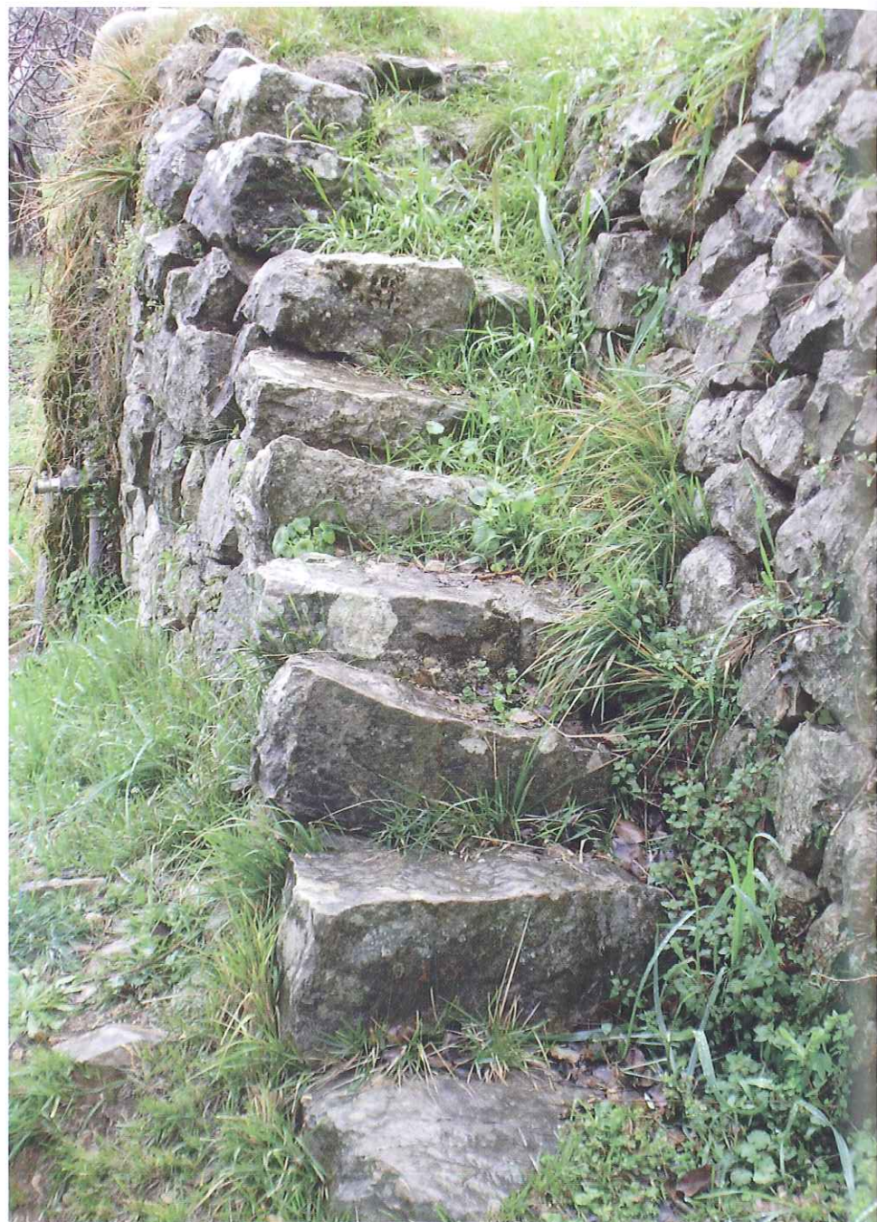
Escaliers Les Fournes, Châteauneuf-Villevieille
