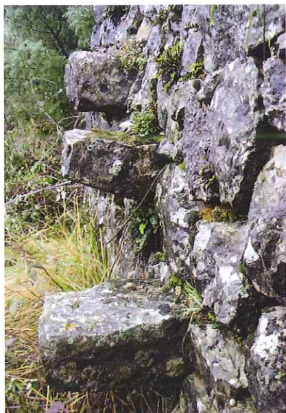
Escaliers volants Coulé de Falcona, Châteauneuf-Villevieille
