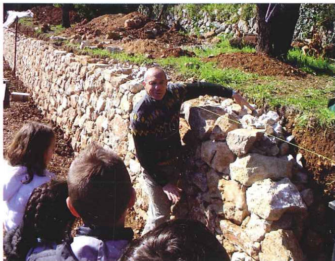
Explication de la technique de la pierre sèche Châteauneuf-Villevieille
