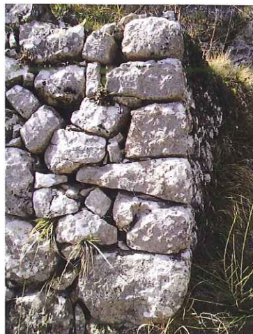
Chaînage d'angle en blocs non équarris Mélière, Châteauneuf-Villevieille
