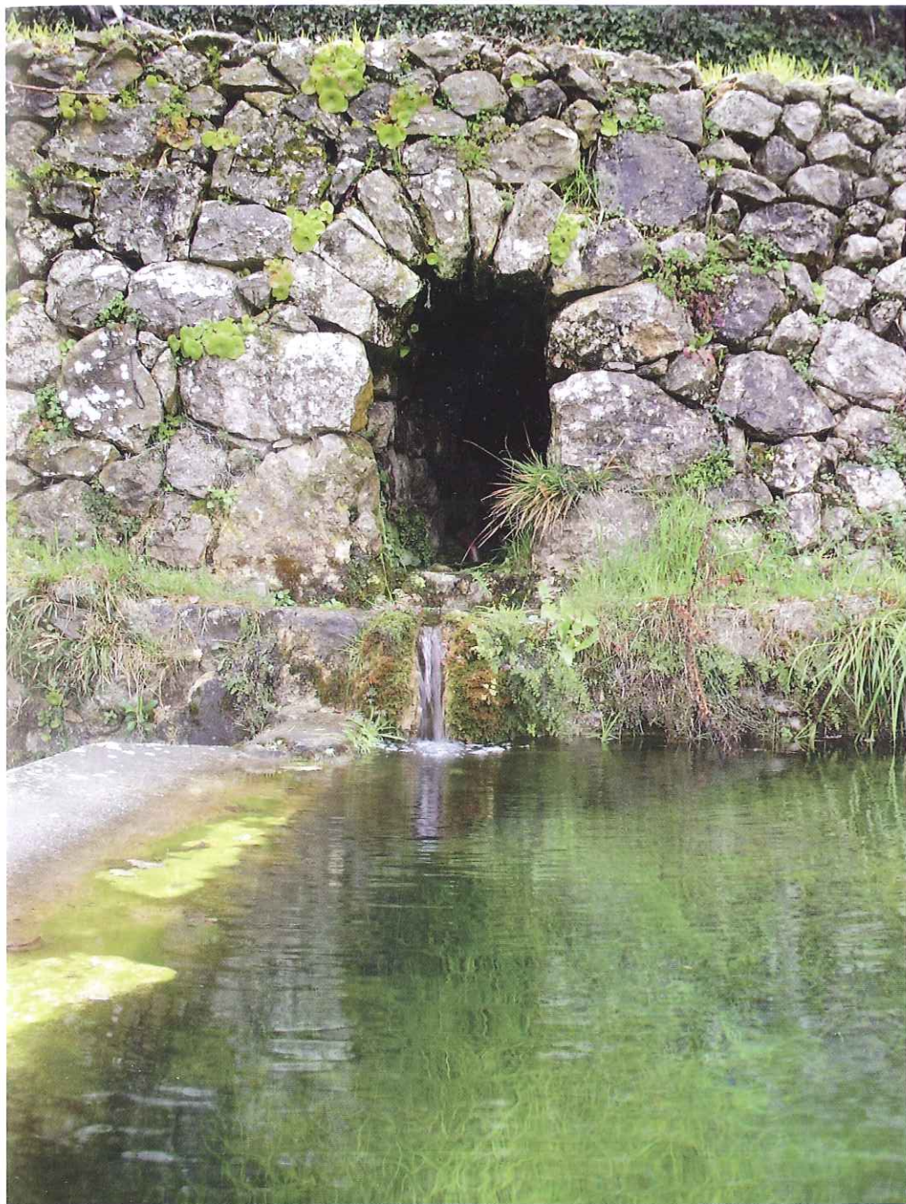
Galerie voûtée en pierres sèches, captage d'une source Les Fournes, Châteauneuf-Villevieille
