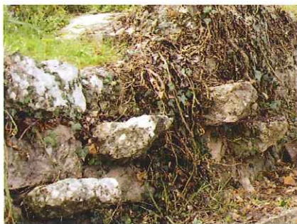
Double escaliers volants Les Fournes, Châteauneuf-Villevieille
