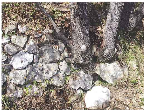
Gonflement d'un mur en pierres sèches avant écoulement Le castellar, Châteauneuf-Villevieille
