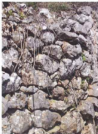
Gonflement d'un mur en pierres sèches avant écoulement Le castellar, Châteauneuf-Villevieille
