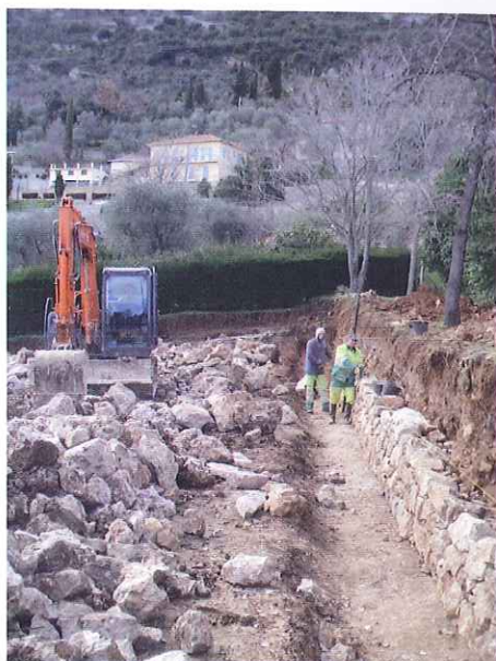
Mur de soutènement du parking du Gerp Châteauneuf-Villevieille
