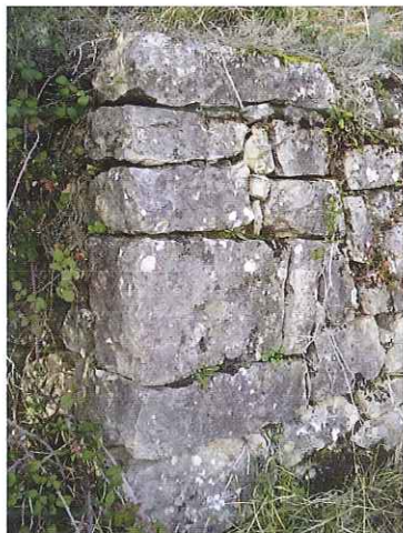
Chaînage d'angle en blocs équarris Coulé de Falcona, Châteauneuf-Villevieille
