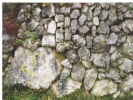
Bloc cyclopéen situé en assise Le Gerp, Châteauneuf-Villevieille
