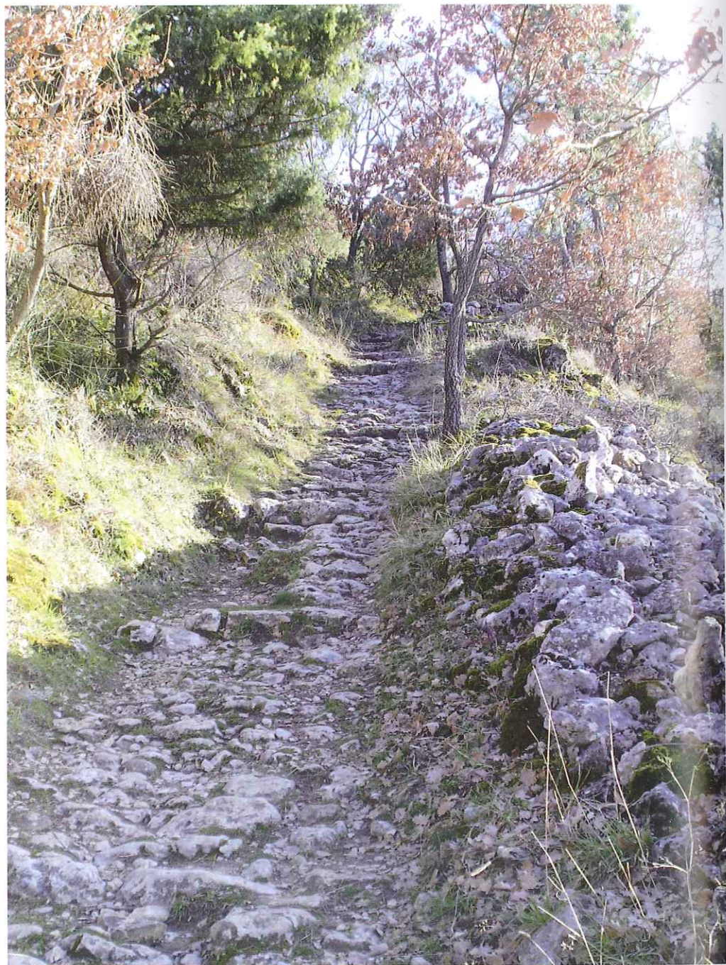
Calade pavée bordée par un parapet de pierres sèches Le Col, Châteauneuf-Villevieille
