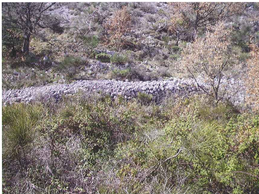
Tas d'épierrement ceinturé par un parement de pierres sèches limitant une ancienne zone de pâture aujourd'hui embroussaillée. Contrefort de la Barre du Midi, Châteauneuf-Villevieille
