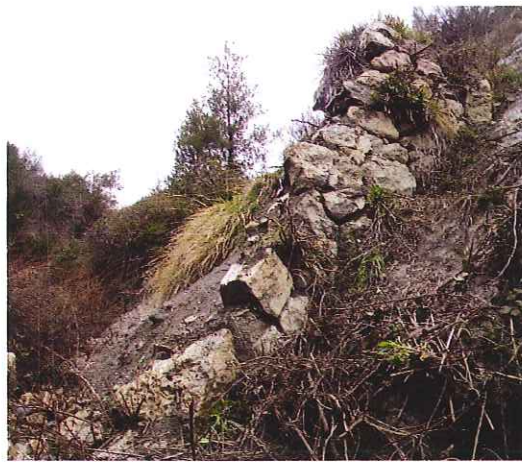
Reste d'un barrage poids implanté en travers du vallon des Fournas Châteauneuf-Villevieille
