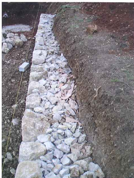
Parement, remplissage et drain Parking du Gerp Châteauneuf-Villevieille
