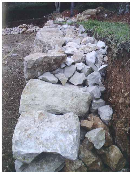
Boutisse, paneresses et pierres de remplissage Parking du Gerp, Châteauneuf-Villevieille
