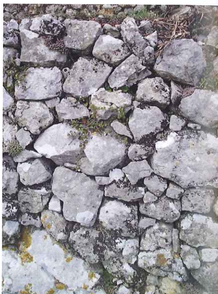
Appareillage en petits blocs de calcaire Les Cabanes, Châteauneuf-Villevieille
