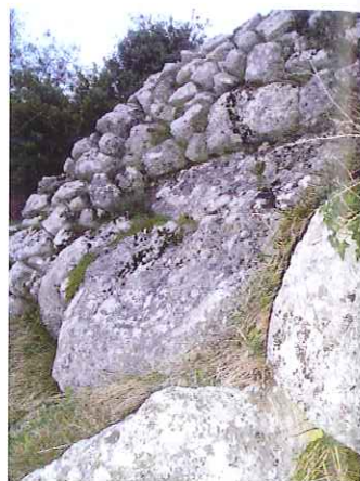
Le mur en pierres sèches prend assise sur le substratum rocheux Mélière, Châteauneuf-Villevieille
