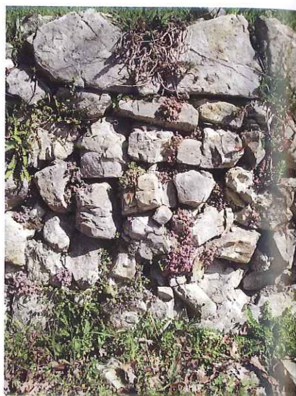
Mur en moellons de calcaire marneux mal appareillé Le Preït, Châteauneuf-Villevieille
