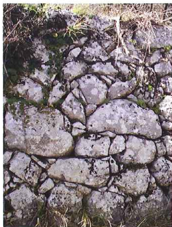
Appareillage soigné en blocs de calcaire Mélière, Châteauneuf-Villevieille
