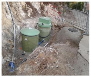
Cette station de relevage mise en place répond à une contrainte technique élevée : relever des eaux usées (chargées) à plus de 85 m de hauteur pour passer le col au débit de 6 litres par seconde.
